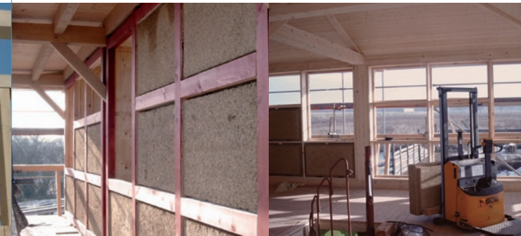
Hanf-Lehm-Elemente im Fachwerk
