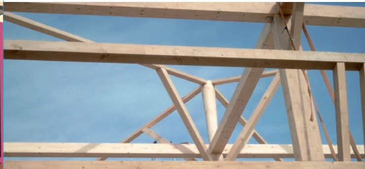
Fachwerk und Dachstuhl
